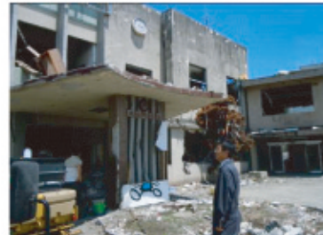
津波の被害を受けた大槌町役場
